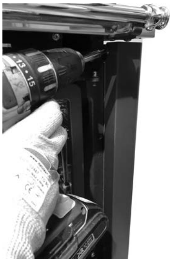
Fig. 39 - Accrocher les parois sur 2 vis
