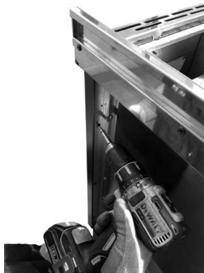
Fig. 40 - Fixer les parois sur 3 vis
